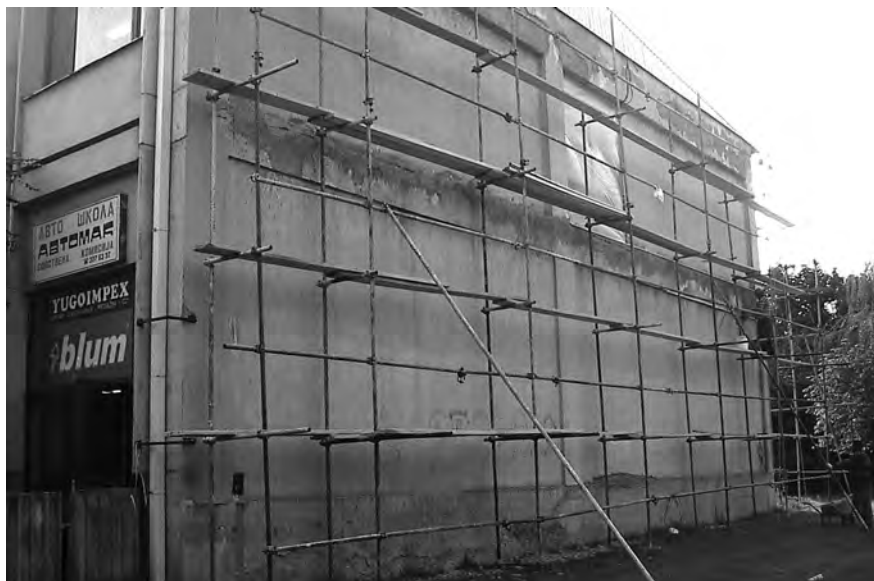
Западната фасада на новиот објект на Кинотеката (за време на реконструкцијата)
